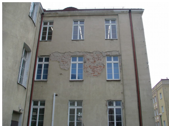
Widok ubytków i zniszczeń tynków na elewacjach zachodnich budynku
