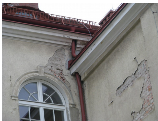
Widok ubytków i zniszczeń tynków na elewacjach zachodnich budynku
