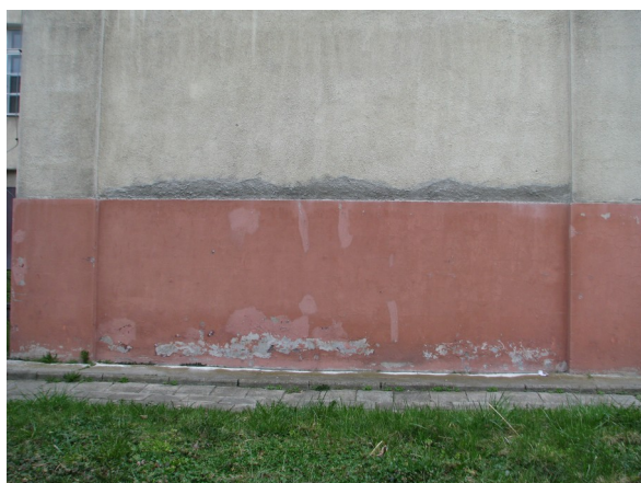
Widok istniejącego cokołu
