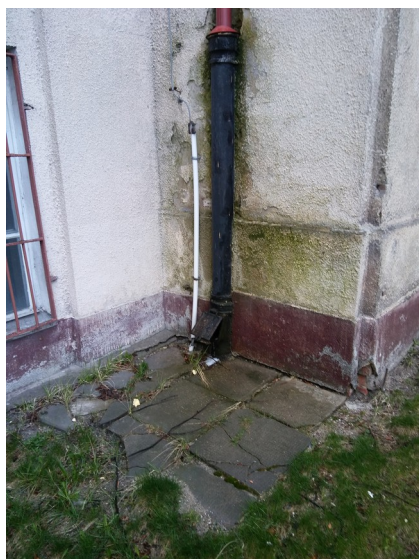
Widok ubytków i zniszczeń tynków na elewacjach zachodnich budynku
