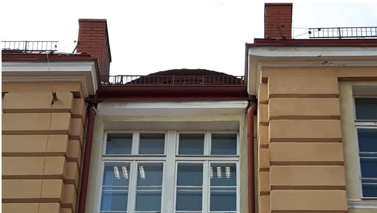
Elewacja frontowa – niefachowo zatarty gzyms łącznika
