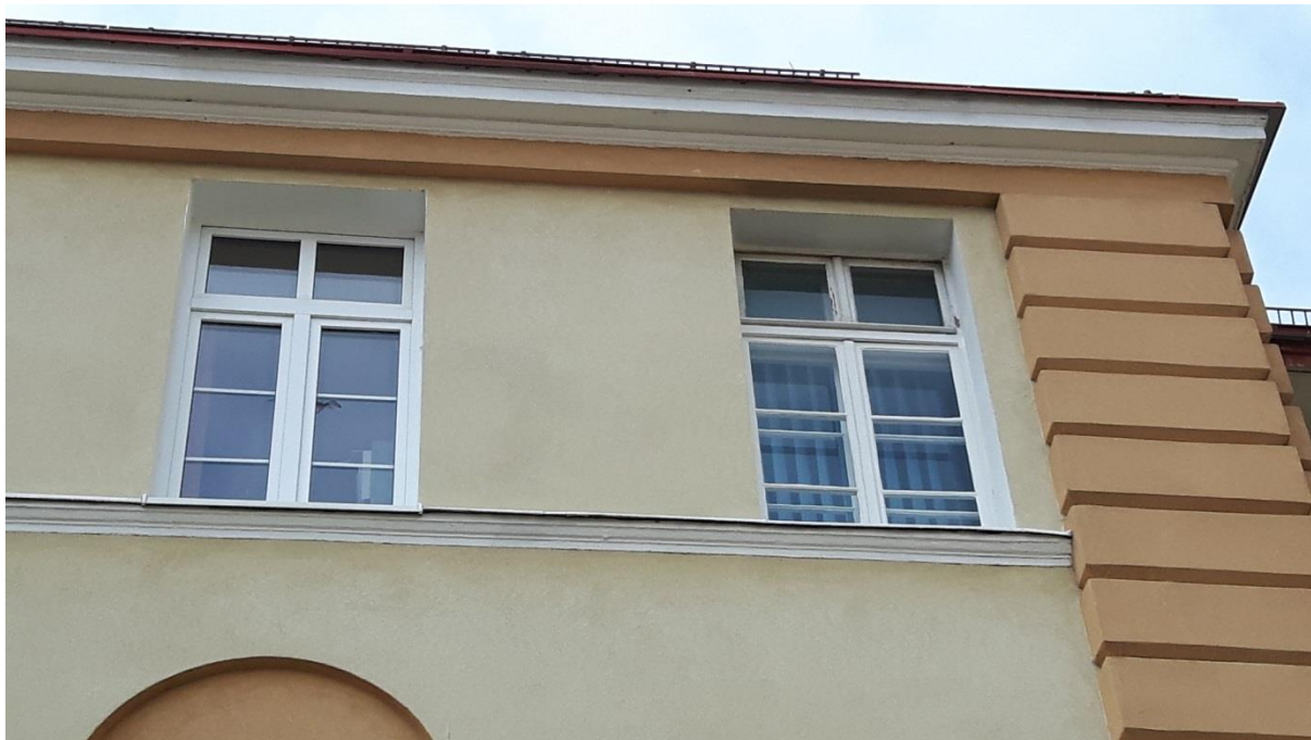
Elewacja frontowa – niefachowo zatarty gzyms łącznika
