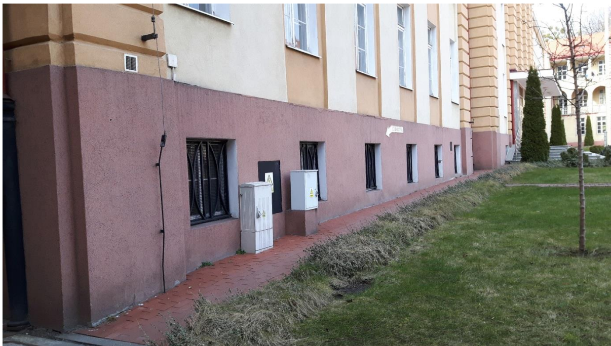
Elewacja frontowa – uszkodzenia cokołów nad gruntem
