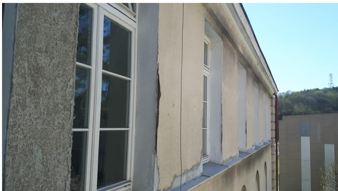
Elewacja skrzydła północnego– nowe obróbki z blachy powlekanej z zacierkami na tynkach
