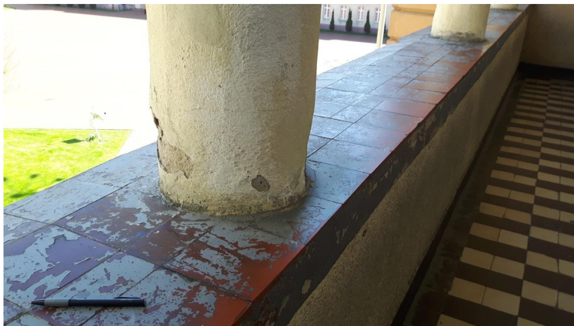
Krużganek północny – zdegradowane obróbki blacharskie dolnego tarasu
