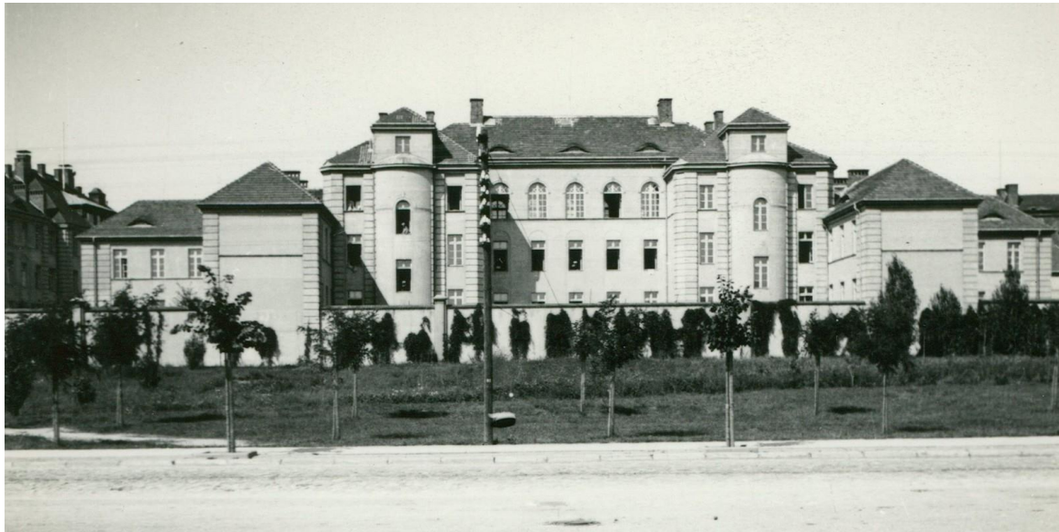
Wzniesiony jako pierwszy w roku 1926, budynek koszarowy (nr ewid. 15), domykający plac apelowy od strony południowej, lata 30-te. Po lewej stronie fragment elewacji Gmachu CWSF. W latach 50-tych budynki połączono narożnym łącznikiem.
