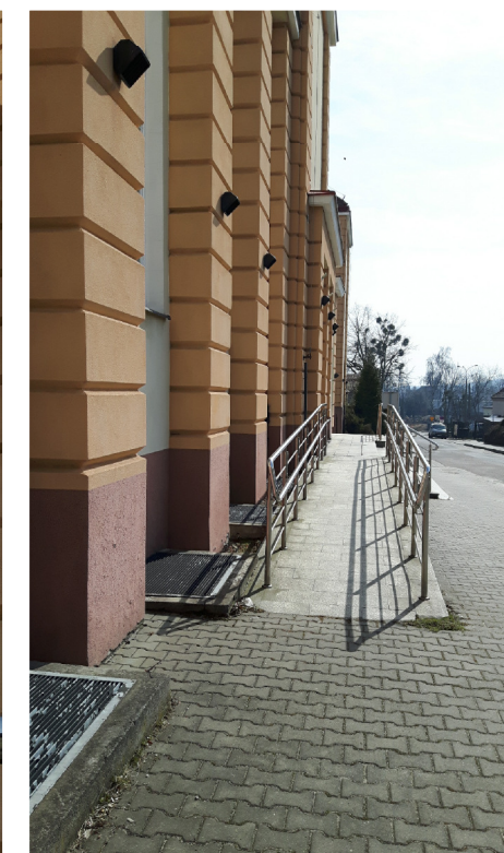
ELEWACJA PARTERU: STAN TYNKÓW ŚCIENNYCH DOBRY, COKOŁY ZANIECZYSZCZONE NA STYKU Z NAWIERZCHNIAMI UTWARDZONYMI I MIEJSCOWYMI USZKODZENIAMI WYPRAWKIPOLIMEROWO-AKRYLOWEJ. STUDZIENKA Z OKNAMI PIWNICZNYMI PO REMONCIE, ŚLEPE STUDZIENKI MIĘDZY LIZENAMI W ŚREDNIM STANIE, DO ROZBIÓRKI. OKNA W CAŁOŚCI WYMIENIONE NA NOWE. PCV W PIWNICACH W DOBRYM STANIE, OKNA WIELKOFORMATOWE DREWNIANE W STANIE ŚREDNIM, SZPROSY W STANIE ZŁYM.
