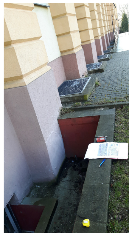
ELEWACJA PARTERU: STAN TYNKÓW ŚCIENNYCH DOBRY, COKOŁY ZANIECZYSZCZONE NA STYKU Z NAWIERZCHNIAMI UTWARDZONYMI I MIEJSCOWYMI USZKODZENIAMI WYPRAWKIPOLIMEROWO-AKRYLOWEJ. STUDZIENKA Z OKNAMI PIWNICZNYMI PO REMONCIE, ŚLEPE STUDZIENKI MIĘDZY LIZENAMI W ŚREDNIM STANIE, DO ROZBIÓRKI. OKNA W CAŁOŚCI WYMIENIONE NA NOWE. PCV W PIWNICACH W DOBRYM STANIE, OKNA WIELKOFORMATOWE DREWNIANE W STANIE ŚREDNIM, SZPROSY W STANIE ZŁYM.
