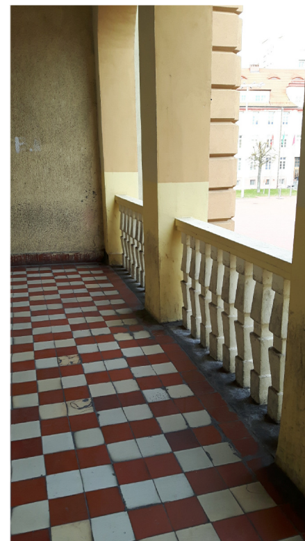
TARAS I PIĘTRA. OBRÓBKI GZYMSU I OKAPU TARASU - ŚREDNI STAN, MOCNE WYKWITY MIKROORGANIZMÓW, USUNIĘTO CERAMICZNE COKOLIKI SŁUPÓW-DO ODTWORZENIA. POSADZKA CERAMICZNA W ŚREDNIM STANIE, POJEDYNCZE KREMOWE PŁYTKI CERAMICZNE SPĘKANE
