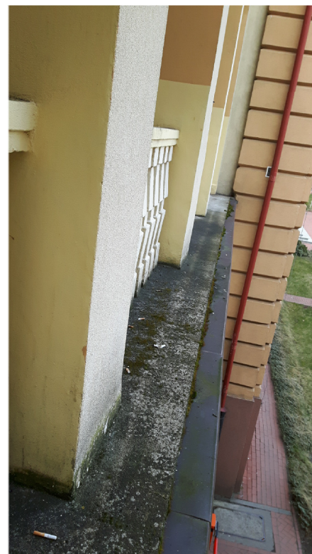
TARAS I PIĘTRA. OBRÓBKI GZYMSU I OKAPU TARASU - ŚREDNI STAN, MOCNE WYKWITY MIKROORGANIZMÓW, USUNIĘTO CERAMICZNE COKOLIKI SŁUPÓW-DO ODTWORZENIA. POSADZKA CERAMICZNA W ŚREDNIM STANIE, POJEDYNCZE KREMOWE PŁYTKI CERAMICZNE SPĘKANE
